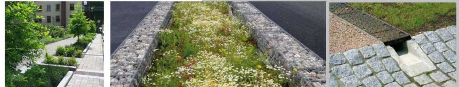
Exemple d'ouvrages de gestion aérienne des eaux pluviales en milieu très urbain
