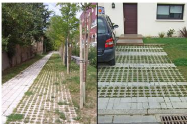
Figure 11 : Exemple de stationnement perméable
