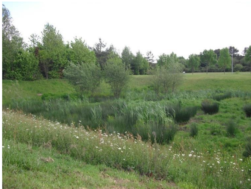
Figure 13 : Bassin des 4 routes à Grand-Fougeray (Source : SETUR)
