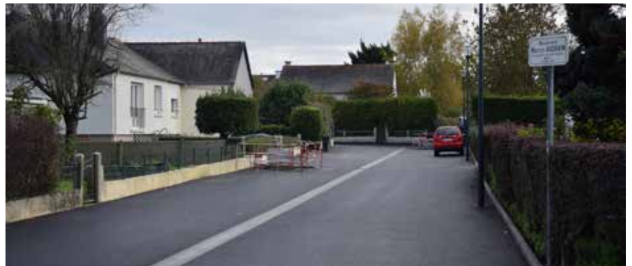
L'aménagement de l'impasse Maurice Audrain est en cours de finalisation.
