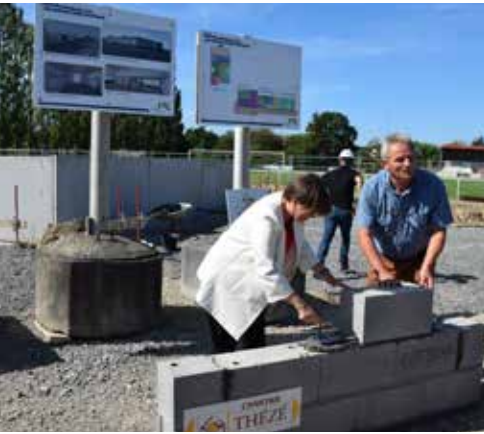
Pose de la première pierre des futurs vestiaires au Stade Paul Ricard.
