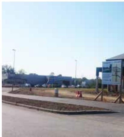
**TRAVAUX** Rue de Châteaugiron, les travaux d'aménagement d'une nouvelle voie verte ont débuté à la rentrée. Cette piste cyclable vient dans le prolongement de celle de la Heurtelais inaugurée en 2017. D'une largeur de 2,50 m avec un garde-corps d'1,20 m au niveau du pont au-dessus de la N157, elle va permettre de relier le Centre-Ville aux zones d'activités en développement.
